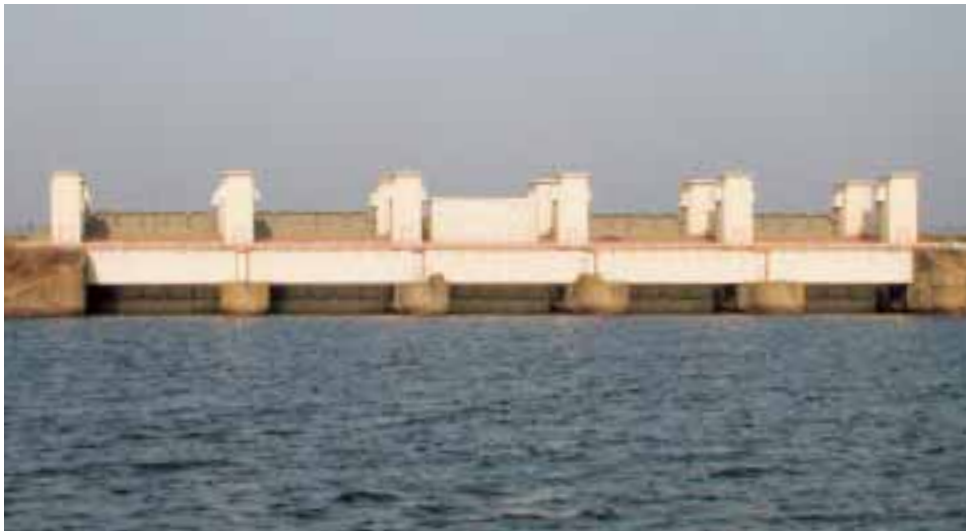
De sluzen in de Afsluitdijk spuien onder vrij verval (Foto: RWS-Directie IJsselmeergebied)
