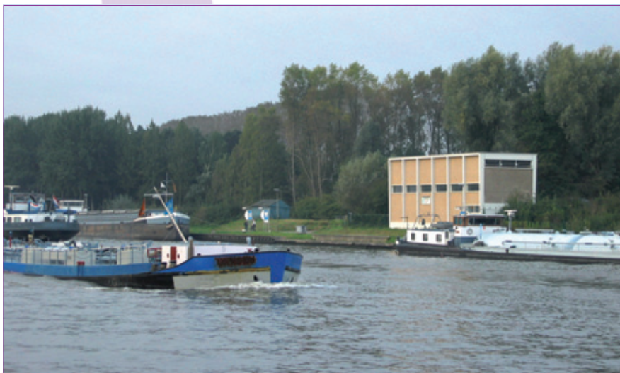
Innamestation WCB van Waternet aan het Lekkanaal
