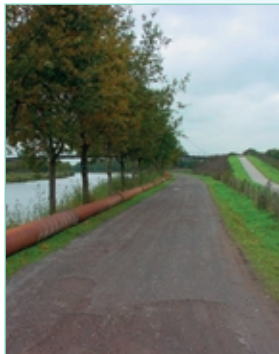
3 km aanvoerleiding 500 mm
