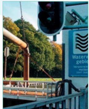
3 km aanvoerleiding 500 mm
