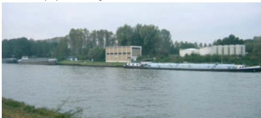
Foto 1.1: Inname pompstation Nieuwegein.
