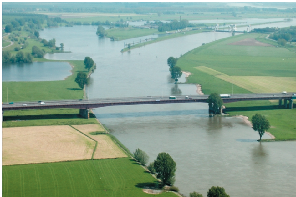
De Lek benedenstrooms van de stuw Hagestein
